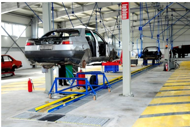
Postrojenje za tretman otpadnih vozila na deponiji Livade , Podgorica
